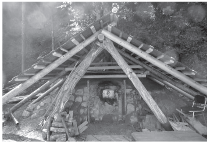
▲苦勞の末、再生された炭窯。製造過程において、火の管理には特に気を配っているとのこと。完成した鞍馬炭は最高品質の黒炭です
